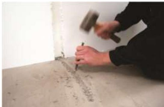
U zidu treba napraviti mesta za dve fleksibilne cevi. Jedna za kabel senzora a druga za napojni kabel same grejne mrežice. Nikada ne postavljajte ova dva kabela u jednu zaštitnu cev. Nakon ovih radnji izdubite kanal u podu otprilike 2cm dubok u koji će biti uvučena cev sa senzorom.
